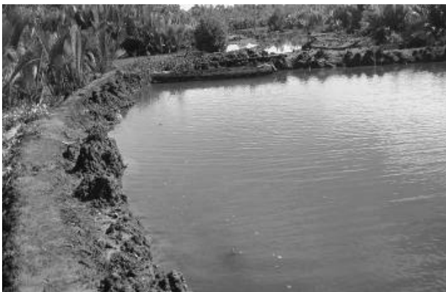
Gambar 4.5. Konstruksi pematang tambak yang terbuat dari tanah.
