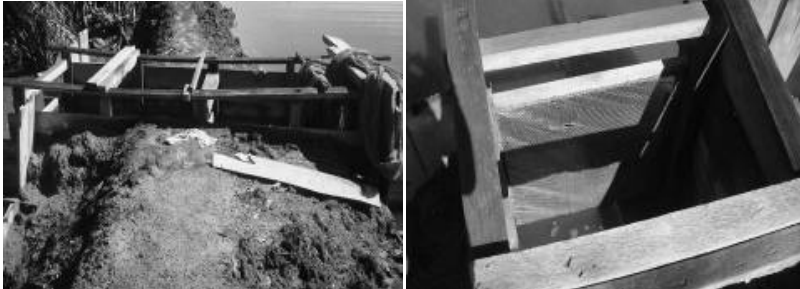
Gambar 4.7. Konstruksi pintu air yang dilengkapi saringan tambak di Kabupaten Mamuju Utara.
