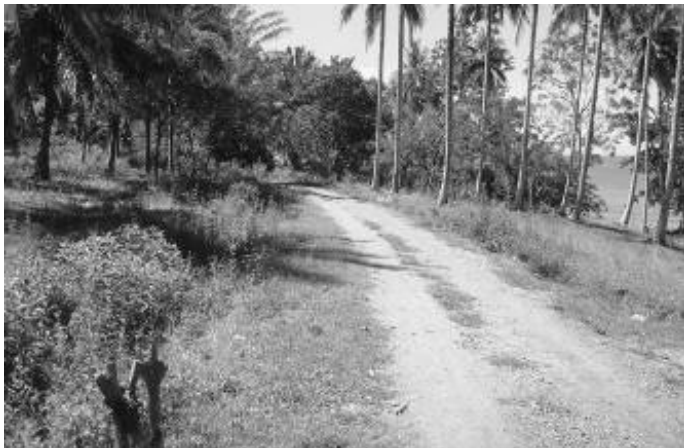
Gambar 4.3. Jalan primer di lokasi pertambakan di Kabupaten Mamuju Utara.
